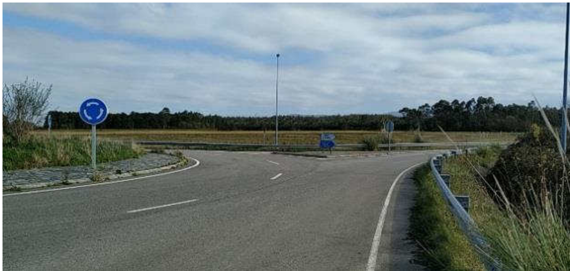
Figura 3.92.- Situación final con las instalaciones desmanteladas
