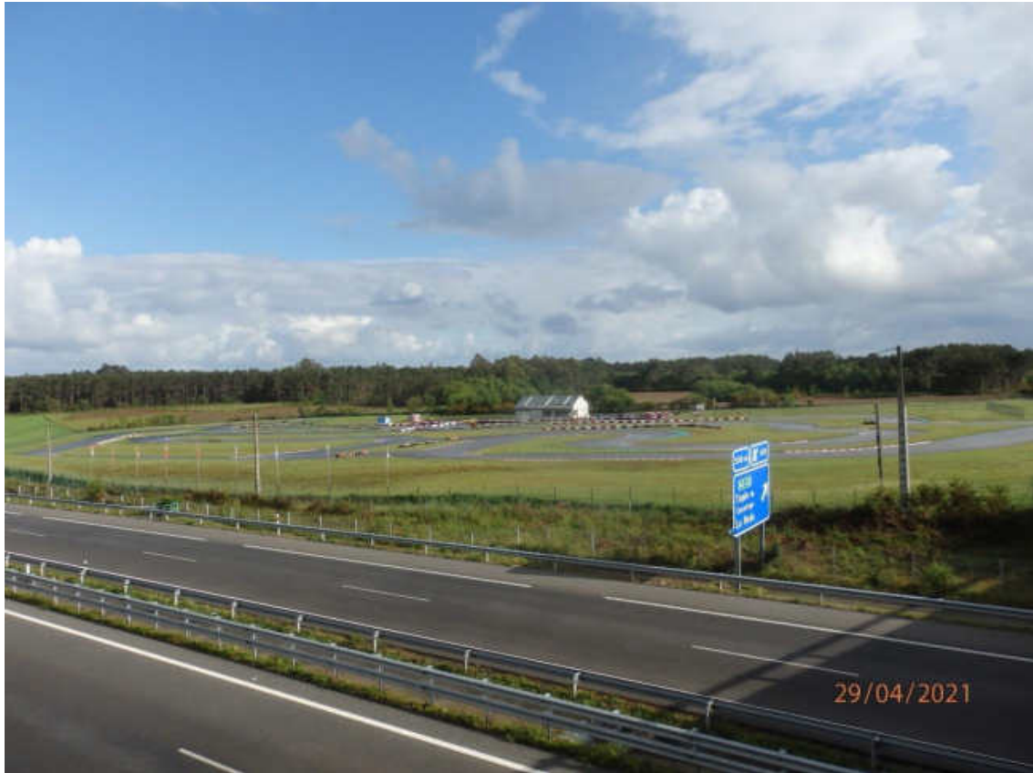
Fotografía 3.12.- Fotografía desde el punto 3 (Camino de Santiago) desde donde no se puede ver la ubicación de la escombrera SW ni el depósito. Solo se podrá ver un pequeño tramo de la escombrera SE a través de la zona donde no existe vegetación arbórea.
