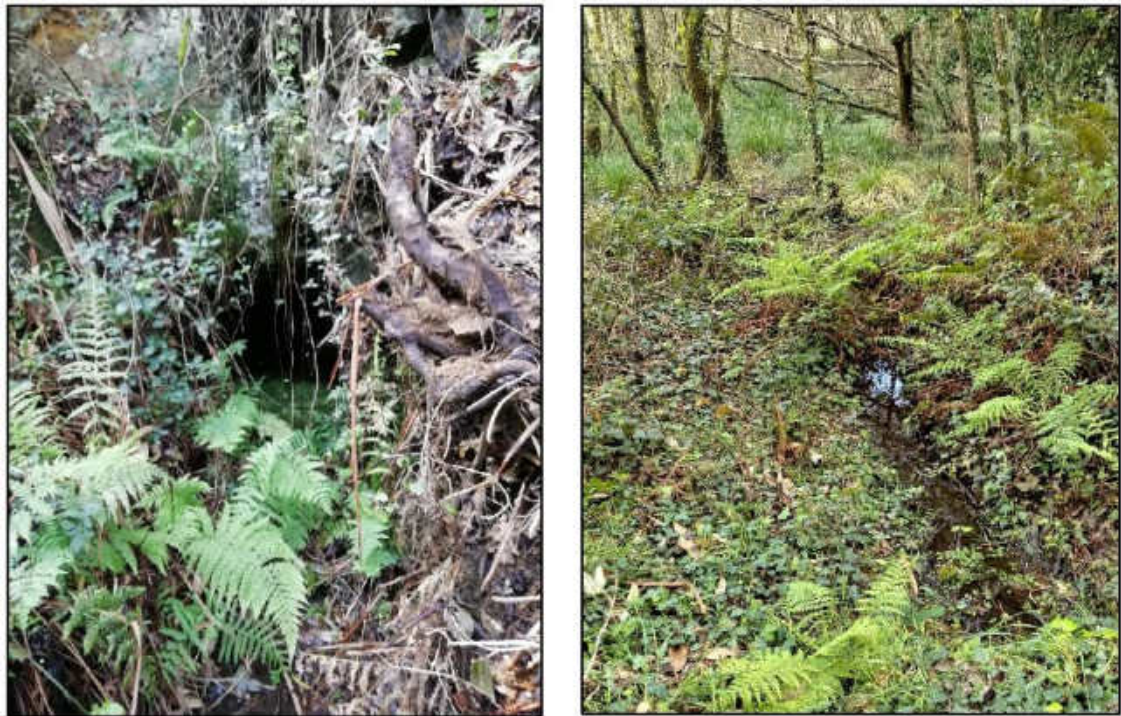
Figura 3.26.- Galería de Mo y drenaje que procedente de ésta entra a la Laguna Seca
