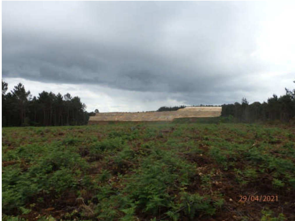
Figura 3.95.- Escombrera SW al comienzo de la operación
