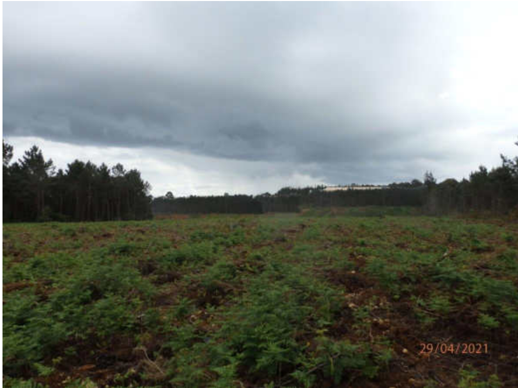
Figura 3.97.- Escombrera SW durante un estadio más avanzado de la operación
