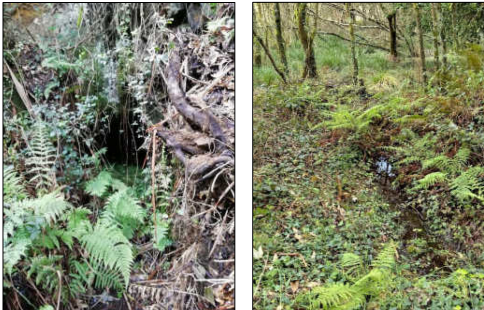
Figura 33. Galería de Mo y drenaje que procedente de ésta entra a la Laguna Seca
